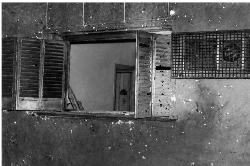
Frente de una de las viviendas vecinas sobre calle Junín después de la explosión. Fotografía preservada por Bompar.
